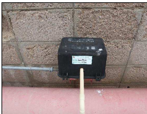
รูปที่ 2-11 ปืนสำหรับต่อเครื่องเป่าอากาศในบ่อบำบัด เพิ่มอัตราการลอยตัวของอากาศ
