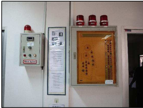
รูปที่ 2-19 ระบบเตือนภัยเมื่อมีความผิดปกติที่ถังเก็บกัก
